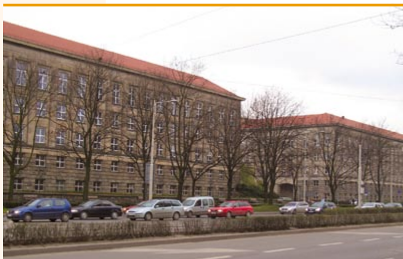
Budynki Wydziału Elektrycznego i dawnego Wydziału Inżynierii Sanitarnej
