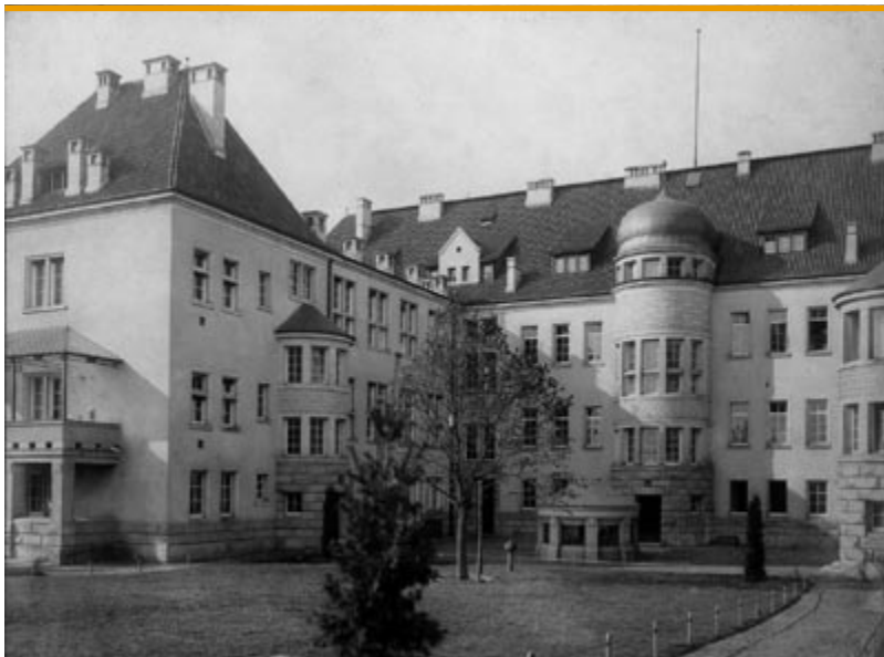
Widok budynku od południa; fot. Eduard van Delden, Heinrich Götz, ok. 1910 r.
