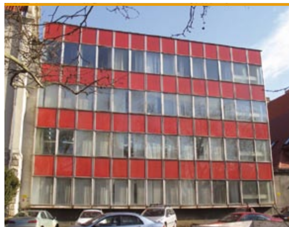
Elewacja zachodnia (fasada), 2006 r.
