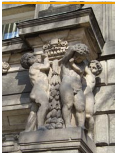
Fragmenty portalu elewacji południowej
