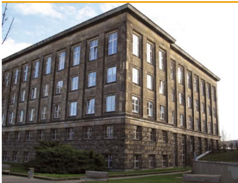
Widok budynku od północnego zachodu
