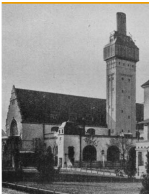
Elewacja wschodnia, ok. 1912 r.
