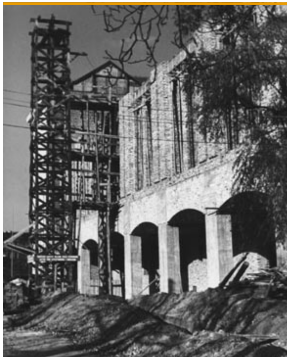
Budowa gmachu Wydziału Elektrycznego, fot. Adam Czelný, ok. 1953 r.
