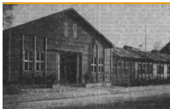
Budynek Instytutu Chemicznej Technologii Włókien Syntetycznych (w głębi po prawej – fragment budynku ówczesnego Instytutu Hutniczego), 1943 r.
