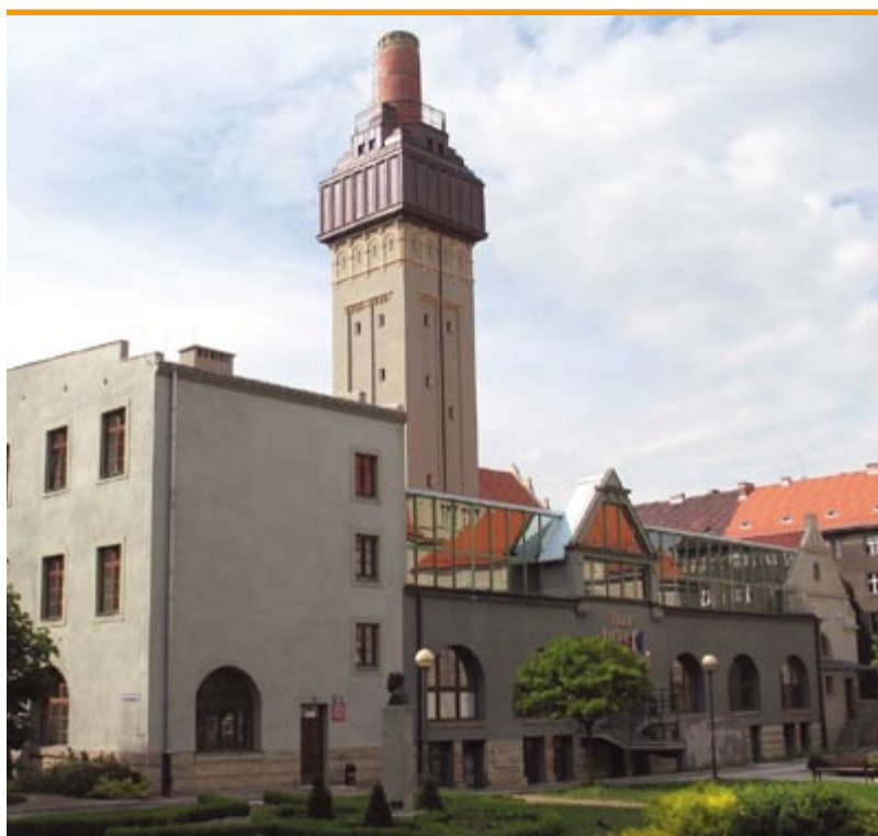
Elewacja wschodnia – stan obecny
