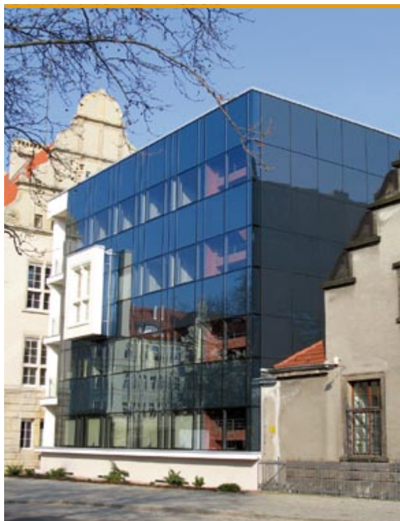
Budynek Instytutu Maszyn, Napędów i Pomiarów Elektrycznych, 2009 r.
