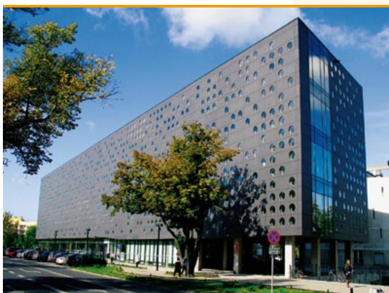
Budynek Zintegrowanego Centrum Studenckiego Politechniki Wrocławskiej
