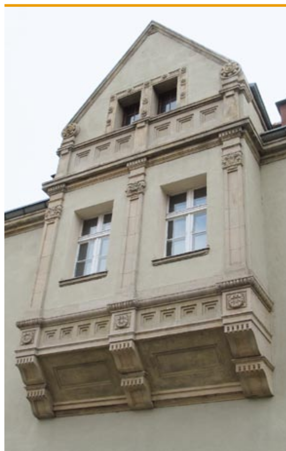
Wykus w elewacji zachodniej
