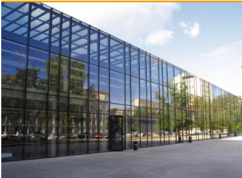
Elewacja dziedzińcowa wschodnia
