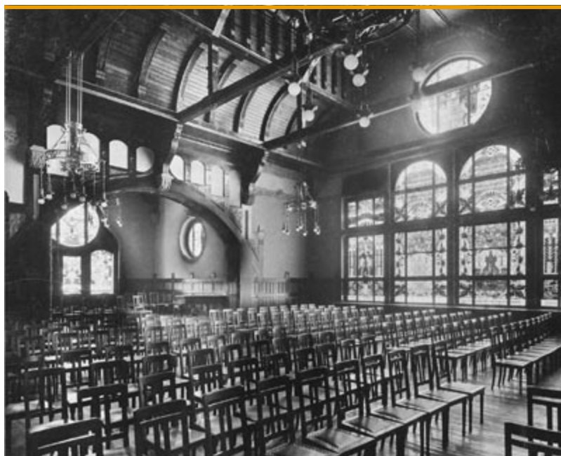
Buildynek główny Szkoły Rzemiosł Budowlanych i Wyższej Szkoły Budowy Maszyn. Wnętrze auli, ok. 1904 r. Dekoracje malarskie Hansa Rumscha. Fot. Ed van Delden, Heinrich Götz
