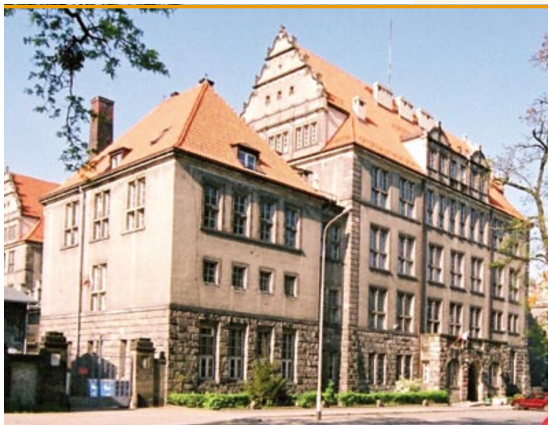
Budynek dawnego Instytutu Hutniczego – widok od północnego wschodu
