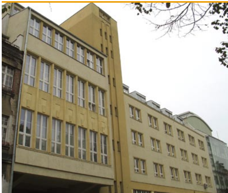
Widok fasady od północnego zachodu
