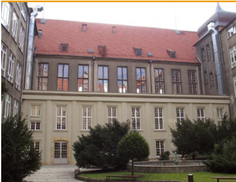
Północna elewacja dziedzińcowa
