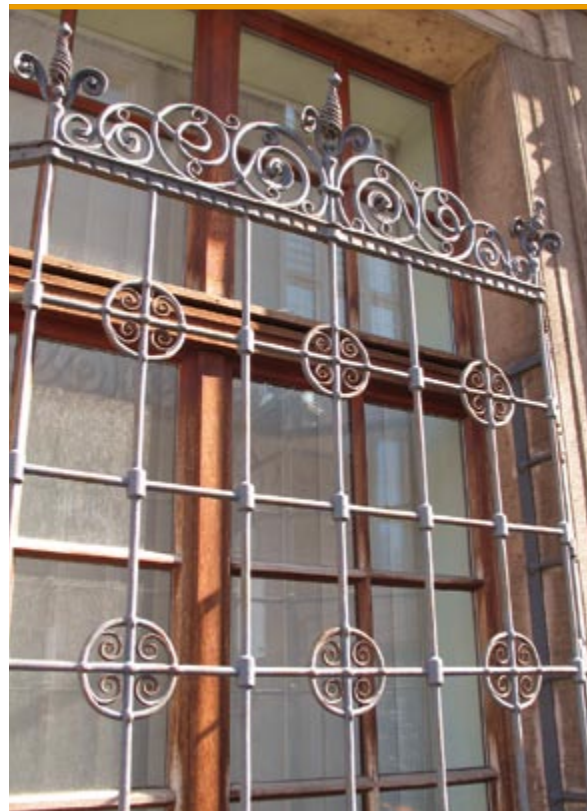
Krata ochronna w oknie elewacji południowej
