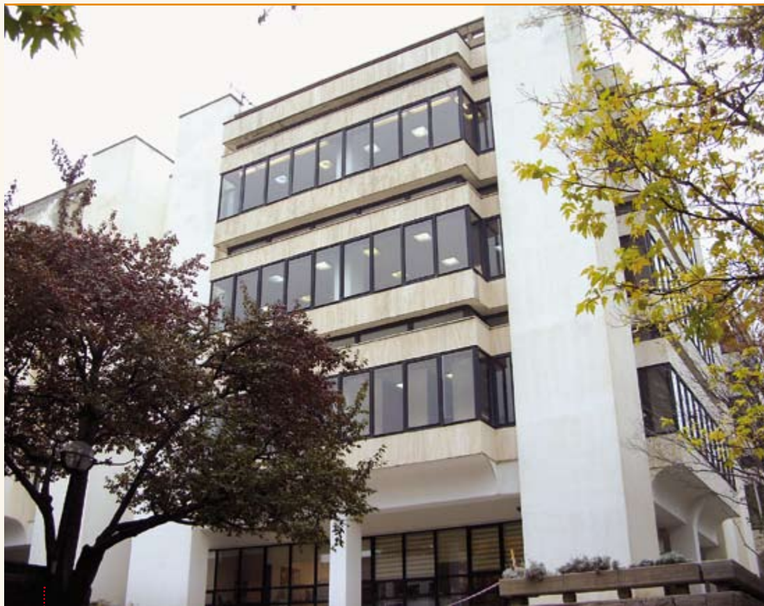
Budynek biblioteki uczelni technicznej w Ankarze
