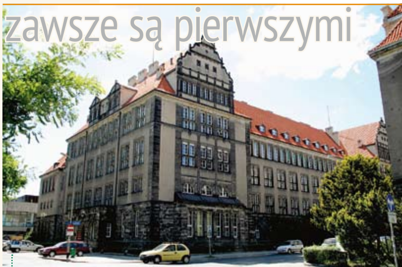
Budynek B-1 jeszcze przed remontem
