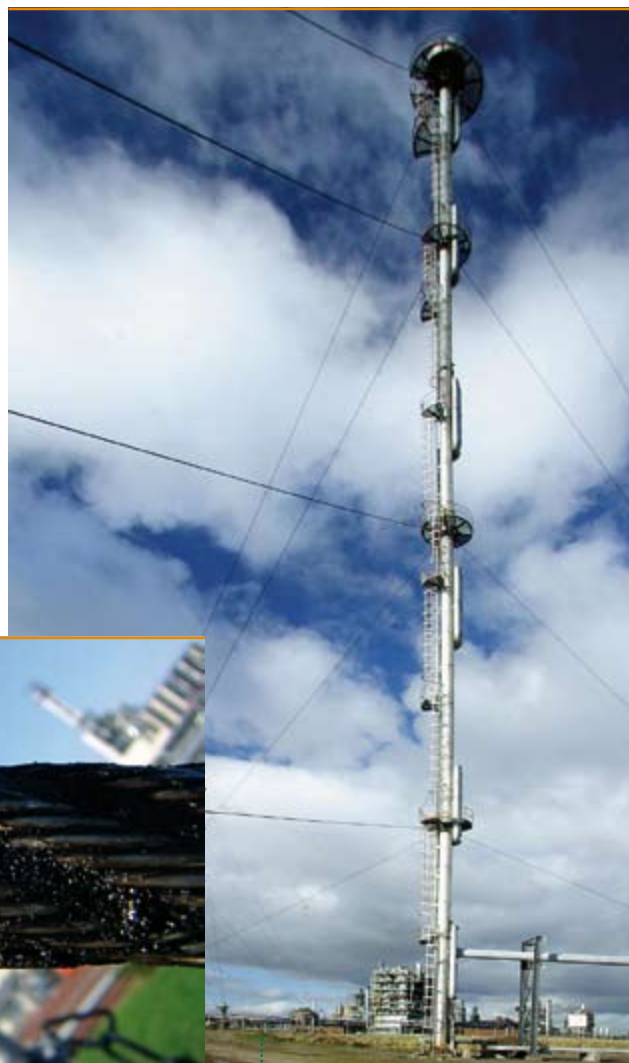
Przykład komina o wysokości 85 m stabilizowanego linami odciągowymi
