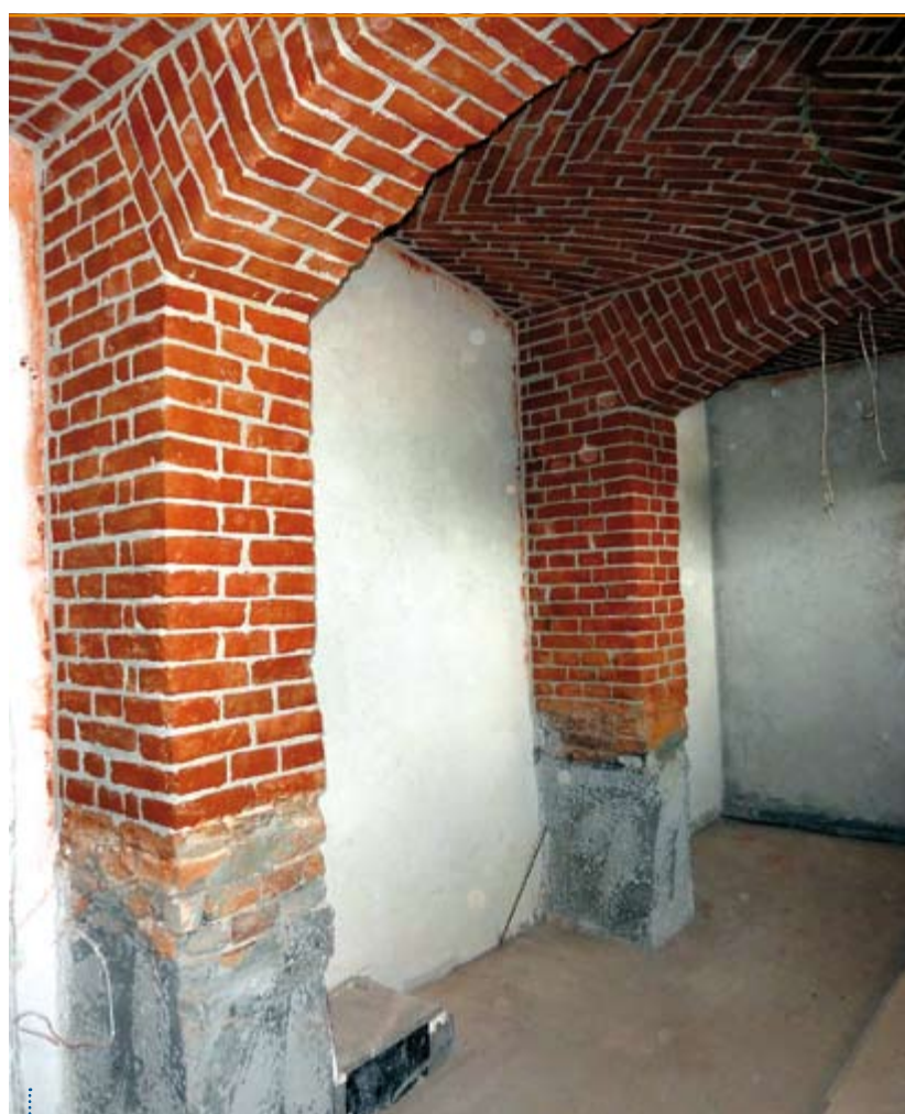
Piwnice po pogłębieniu
