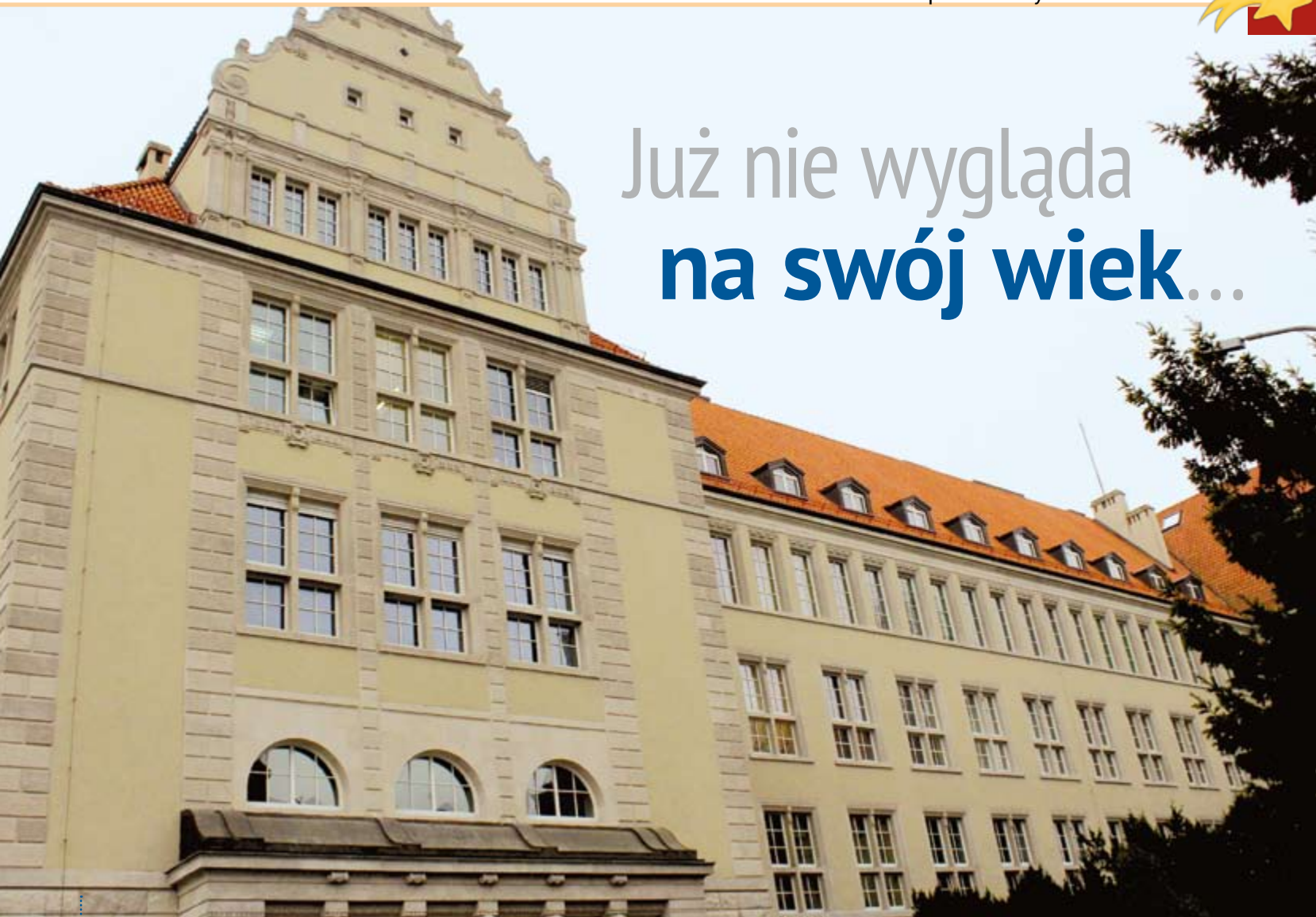
Ściana budynku od ul. Łukasiewicza
