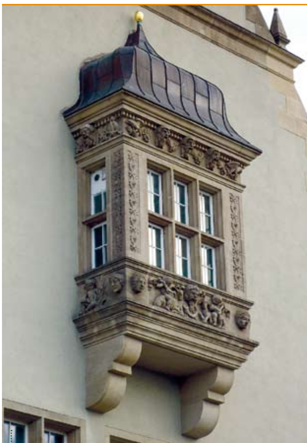
Wykusz zachodniej ściany szczytowej
