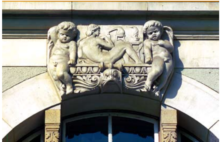
Zwornik zachodniego okna holu parteru
