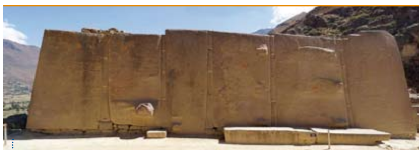
... Granitowe bloki kamienne twierdzy w Ollaytantambo
