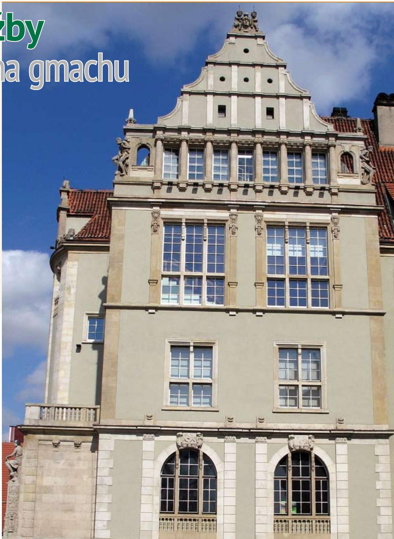
Południowa elewacja zachodniego skrzydła starszej (północnej) części Gmachu Głównego. Strefy parteru, drugiego piętra i szczytu zdobią wątki utrzymane w konwencji rzeźb z pobliskiego portalu
