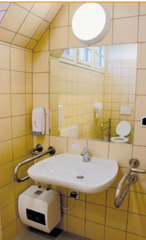
Toalety przystosowano dla osób niepełnosprawnych
