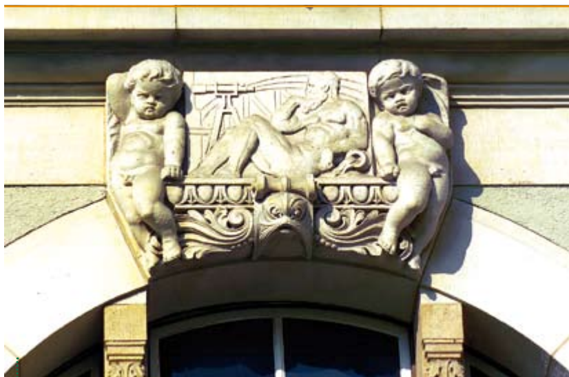
Zwornik wschodniego okna holu parteru
