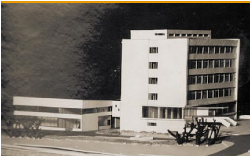
Budynek Zakładu Hydrometalurgii i Chemii Pierwiastków Rzadkich, ul. Norwida 4. Widok od strony ul. Ludwisarskiej (makieta). Projekt: Stanisław Knysz, styczeń 1967 r.
