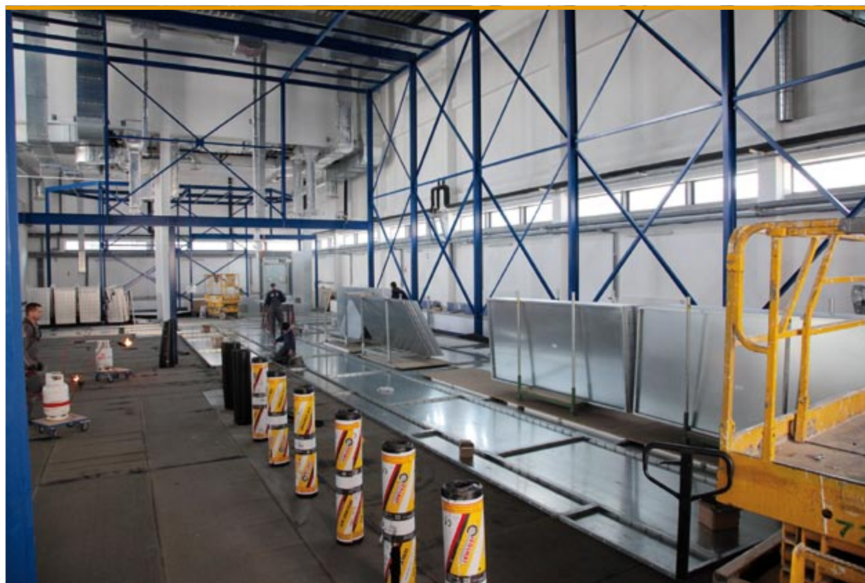
Wiosną ub.r. montowano podłogę w budynku C-15 pod zaplecze badawcze Wydziału Elektroniki. Od kilku miesięcy wydajnie pracuje tam już unikalna aparatura badawcza
