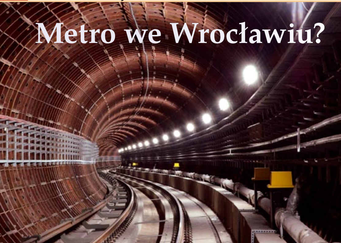
Tunel metra zrealizowany metodą górniczą
