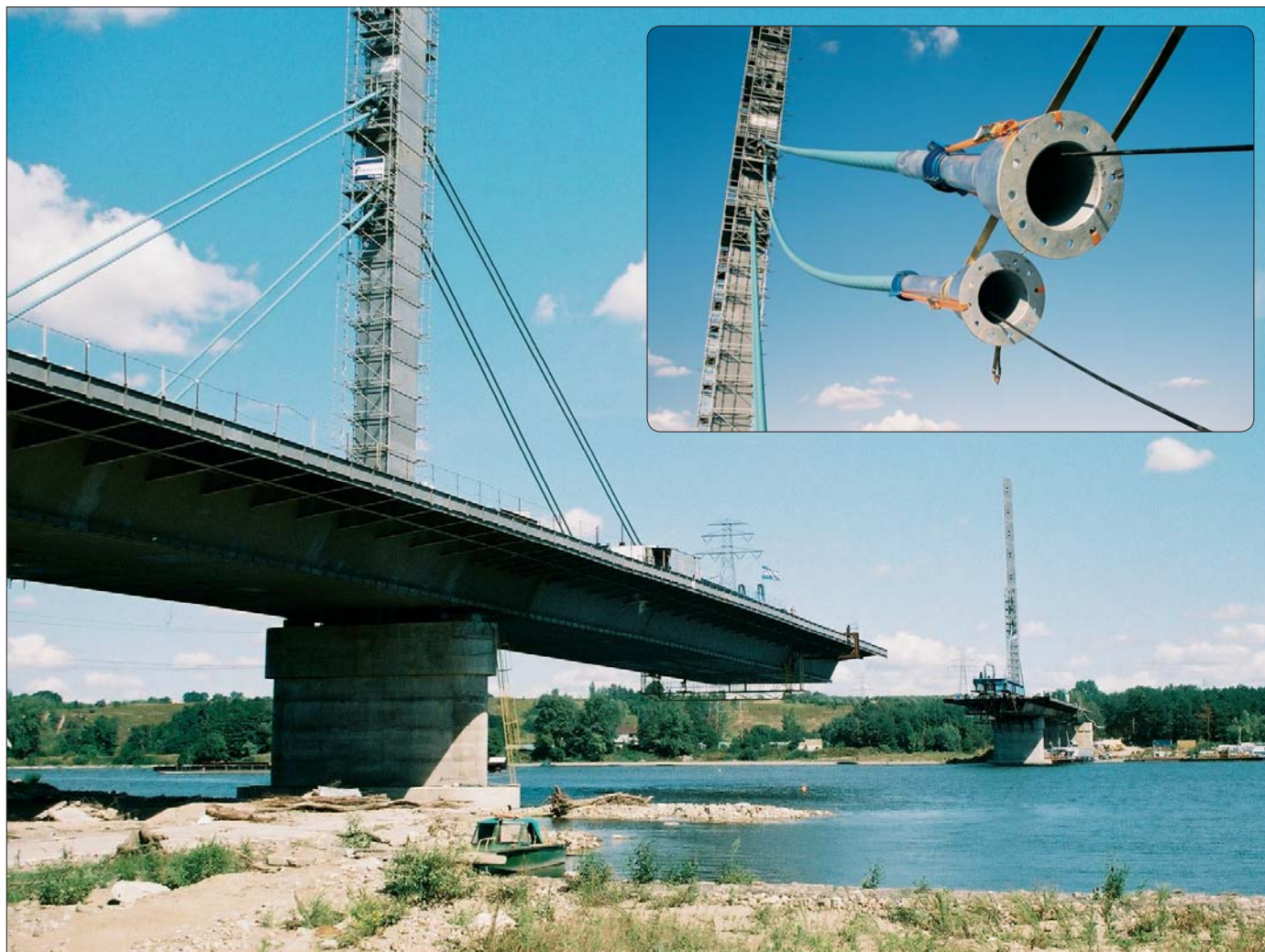
Budowa mostu w Płocku, lato 2004 r.
