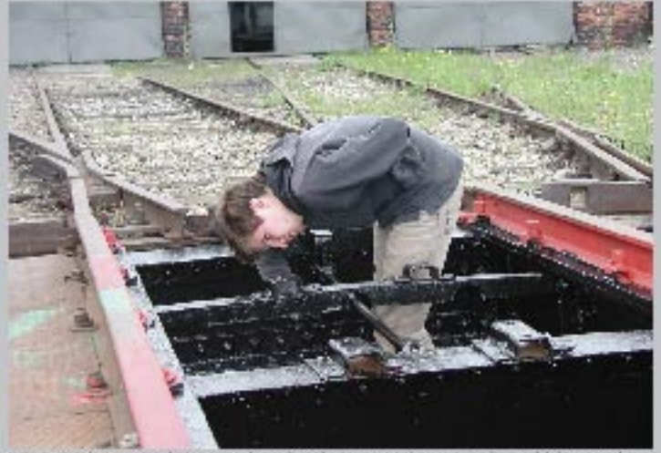
W wyniku konserwacji zabłytkowej, obrotnicy parowozowni z 1900 roku obejmującej jej pomost i sterownię odzyskała ona dawną świetność i napęd.
