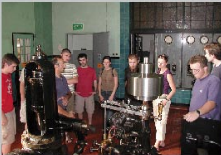
W elektrociepłowni w Luboszewie
