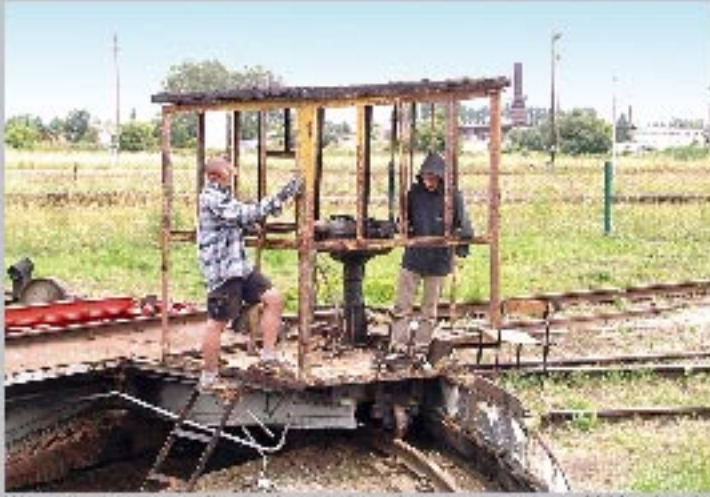
W wyniku konserwacji zabłytkowej, obrotnicy parowozowni z 1900 roku obejmującej jej pomost i sterownię odzyskała ona dawną świetność i napęd.
