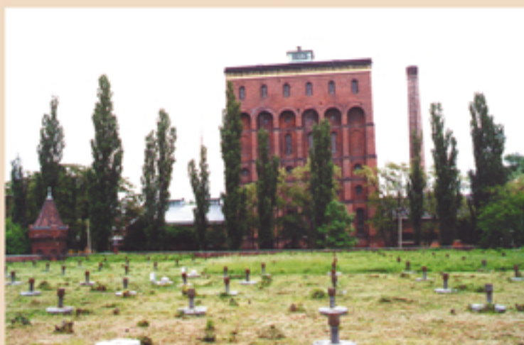
Zbiornik wody czystej
