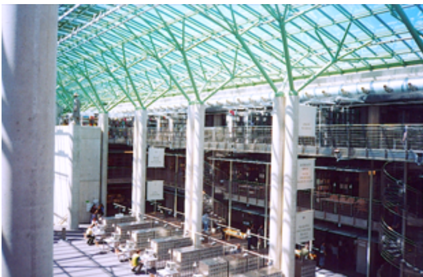
Biblioteka Uniwersytecka w Warszawie: stal, beton i szkło. Widok na stanowiska komputerowe i katalogi tradycyjne.
