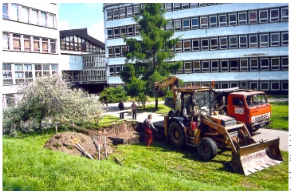
16.05.2001 r. godz. 10.00. Prace trwają. Wykop prawie gotowy.
