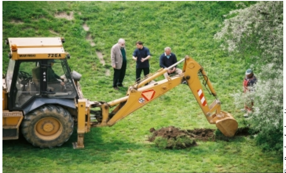
15.05.2001 r. godz. 13.30. Pierwsza łyżka ziemi wybrana pod czujnym okiem red. A.Kisielnickiego
